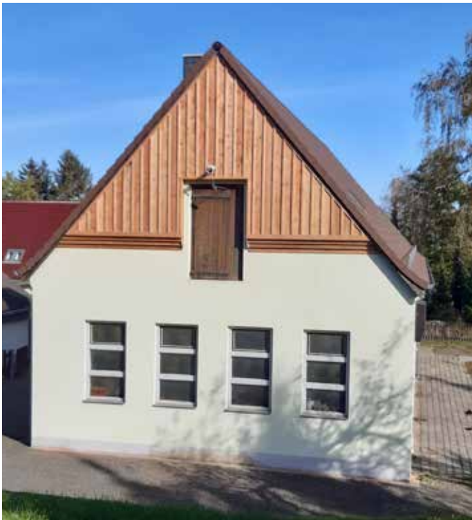
Forstgarage an der Leipauer Straße in Olbersdorf
